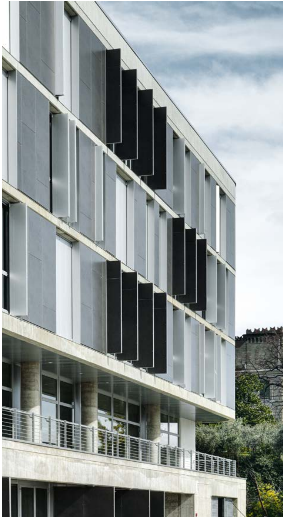
Hinterlüftete Fassaden | Nietsystem
