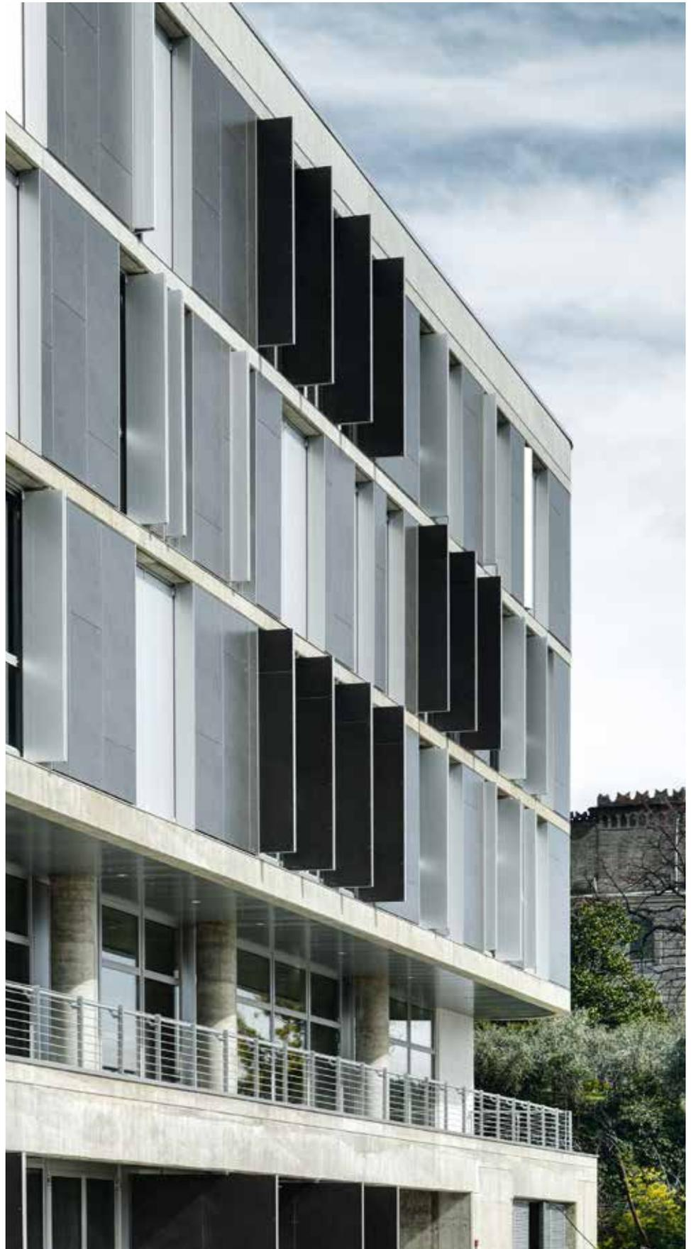
Facciate ventilate | Sistema a rivetti
